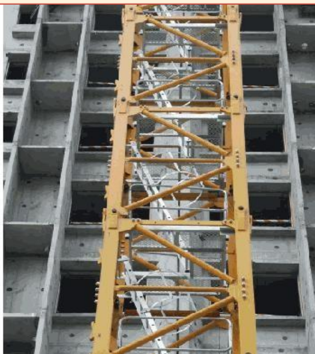
塔吊标准节优先选用斜爬梯型
