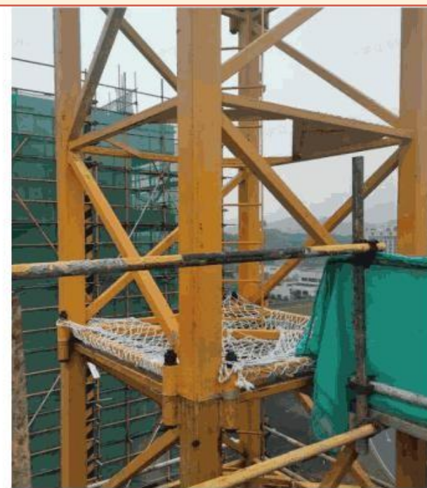
塔吊空中走道对应的标准节 应设水平兜网
